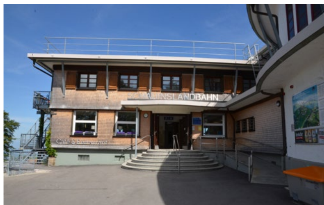
Zone d'accès de la station d'altitude
