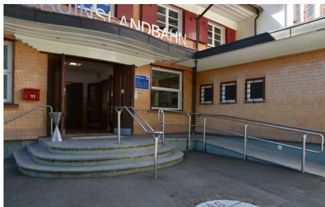
Zone d'accès de la station aval
