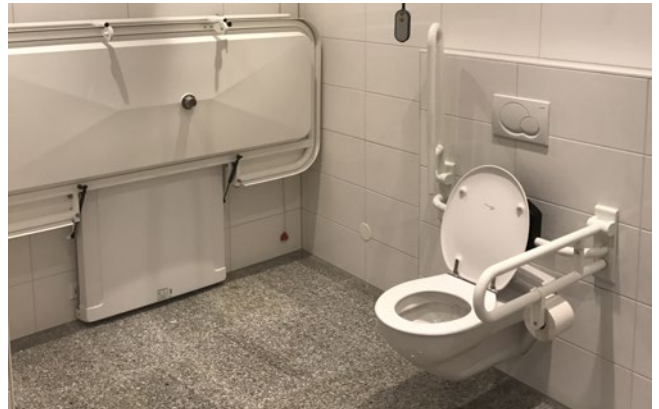
Behinderten-WC in der Talstation
